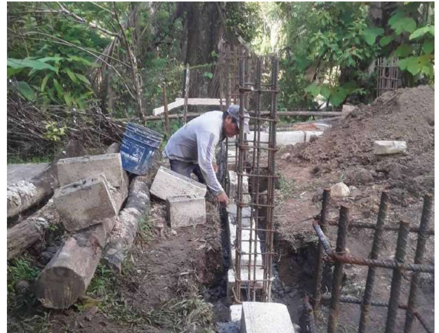
Caralampio colocando block para recibir la cadena. Fotografía: Equipo de Loma Bonita.
