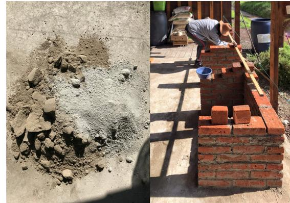
Mezcla de mortero-arena y alineación con paño de firme exterior. Foto: Saúl Nava.
